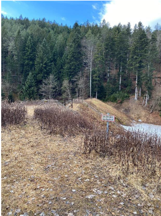
Staudamm gegen Hochwasser
